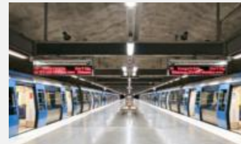
地鐵車站公共照明
